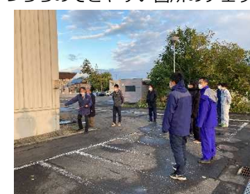
外壁塗装の確認
