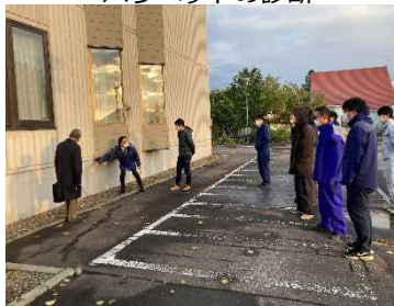
コンクリートのひび割れ確認
