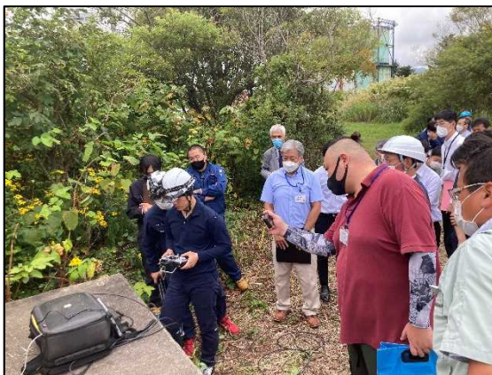
下水道調査ドローンの操作
