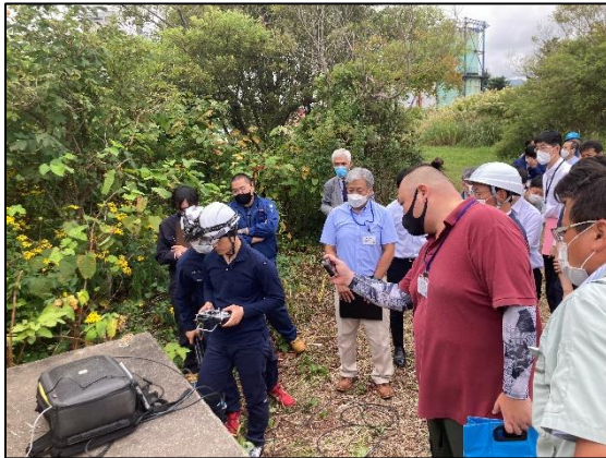
下水道調査ドローンの操作
