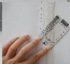
ひび割れ測定
