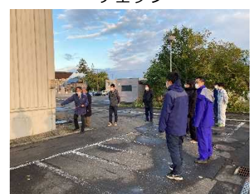
外壁塗装の確認
