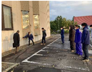
コンクリートのひび割れ確認
