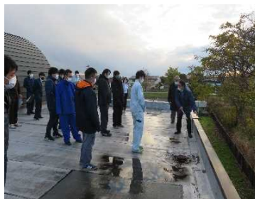
パラベットの診断
