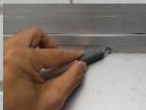
シーリングチェック
