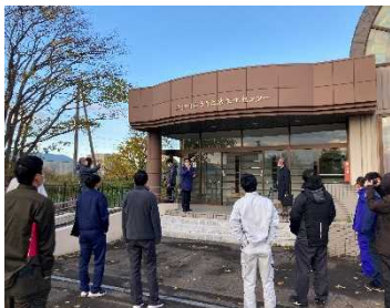
タイルの打音検査
