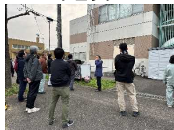
タイルの打音検査
