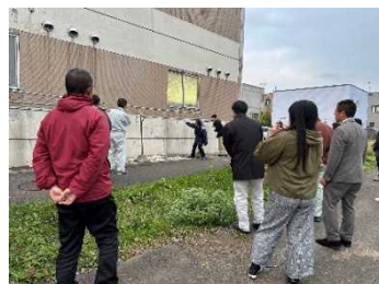
外壁塗装のチェック
