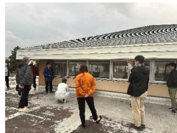
ひび割れ確認
