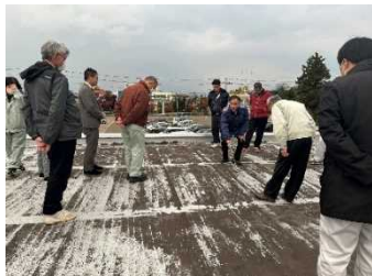
屋上排水のチェック
