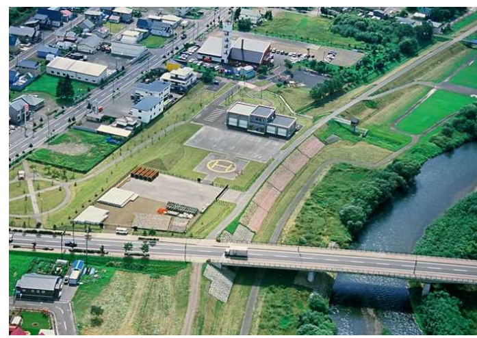
標茶地区河川防災ステーション
