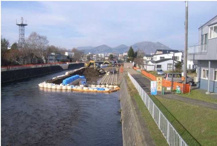
図2-6 弟子屈町市街地における河道掘削状況
