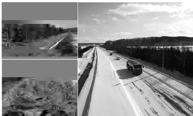
図-1 更喜苦内防雪区間に設置した両側防雪林
