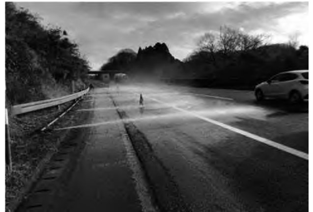
写真2 定置式薬液装置散布状況
