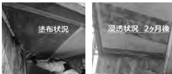
写真1 岩滝橋上り A 1 ゲル塗布状況
