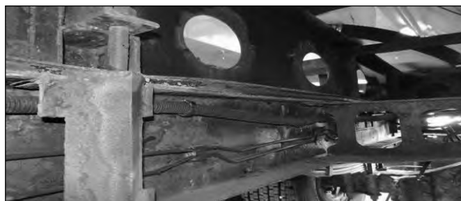
写真-1 シャシフレーム内側状況
