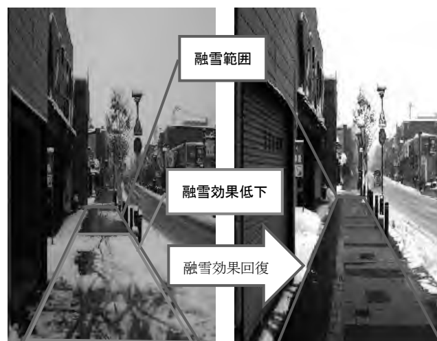
写真1 放熱管洗浄前後の融雪状況比較
