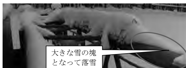
図3 無対策箇所からの落雪
