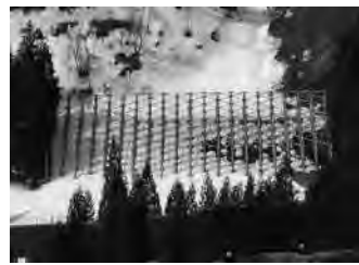
写真3 減勢群杭・雪崩発生区積雪状況（UAV撮影）
