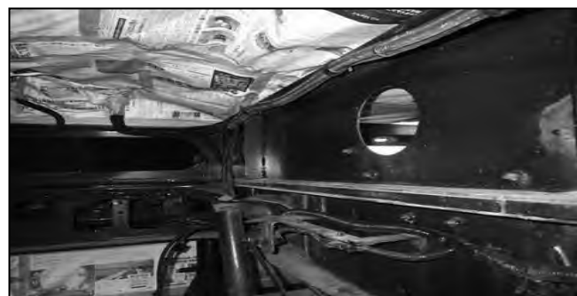
写真-3 塗料B シャシフレーム内側状況
