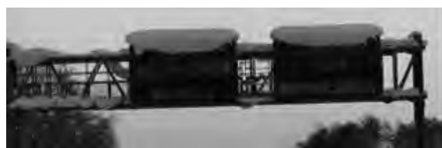
図1 道路情報板に発生した冠雪
