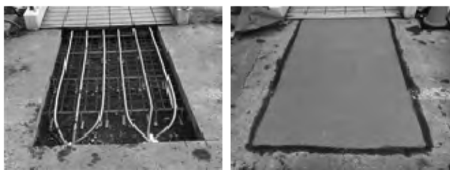
写真1 実験施設施工状況
