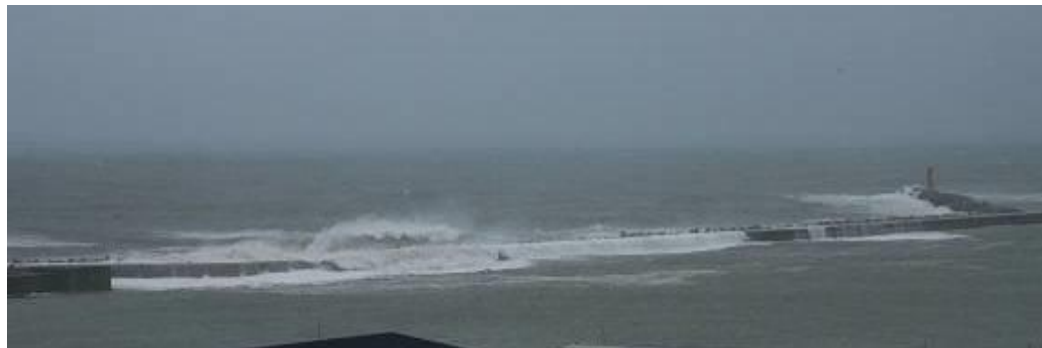
荒天時における防波堤(南)の越波状況
