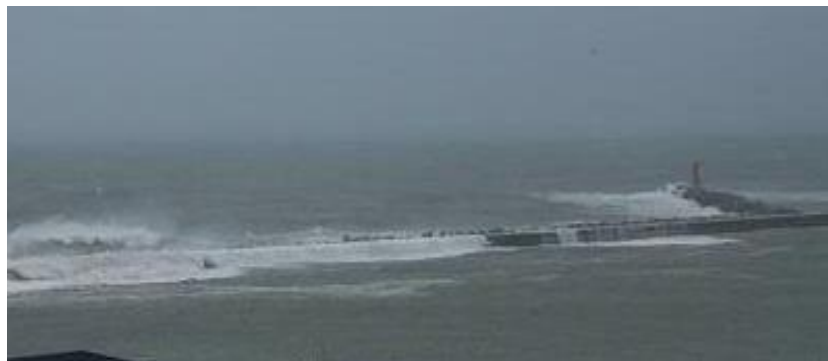
網走港新港地区における防波堤(南)の越波状況
