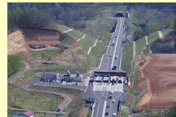
写真：小樽開発建設部
