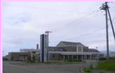
写真：小樽開発建設部
