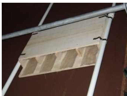
北栄橋 橋脚へのバットボックスの設置状況
