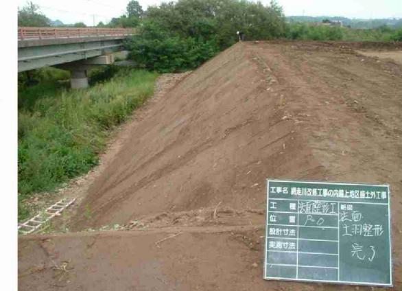
写真6-2 河道掘削土を用いた堤防整備
