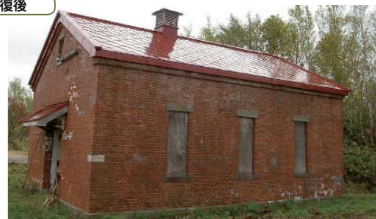
伝統の技「菱葺き」屋根修復完成です
