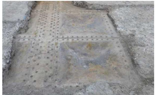
写真11 バックルプレート上面
