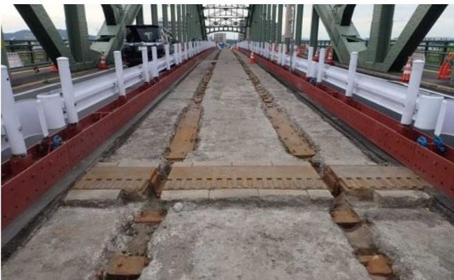
写真9 路面電車跡（鋼製の枕木）
