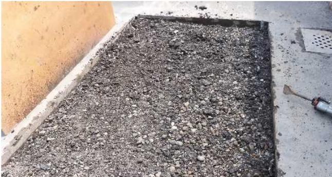
写真5 アスファルト舗装(基層)の砂利化(4径間目)
