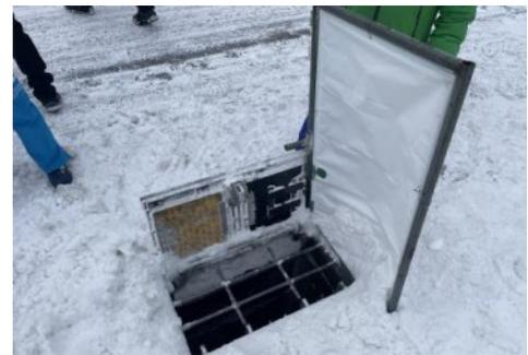
写真7 機械投雪補助具
