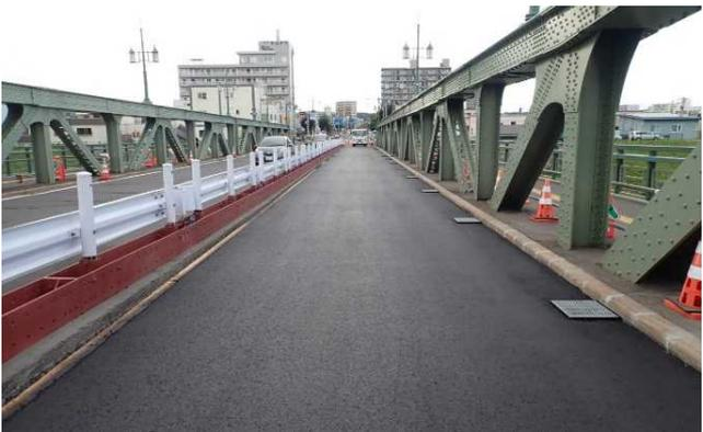
写真14 舗装新設後の路面（基層）
