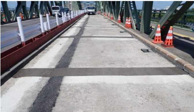
写真13 コンクリート打設後の床版面
