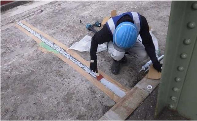
写真12 横桁部のシール材設置状況
