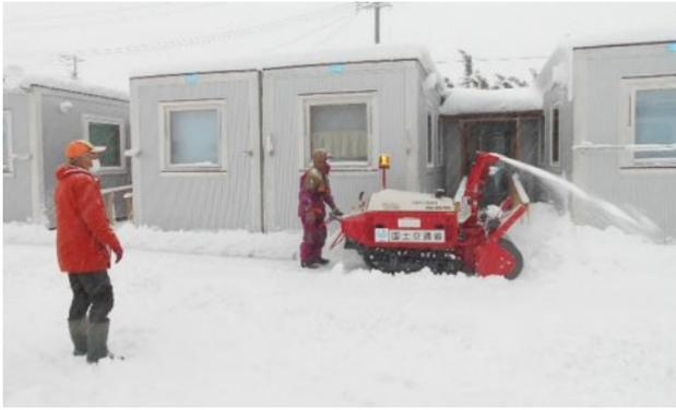
写真7 自治体支援用ハンドガイド式除雪機による除雪状況
