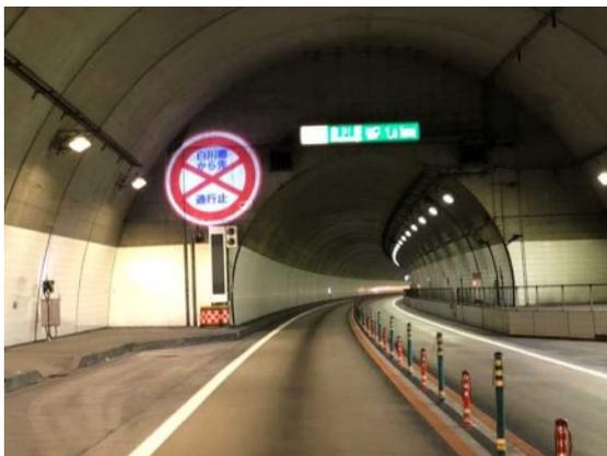
写真 3. プロジェクターによる通行止案内(壁面)
