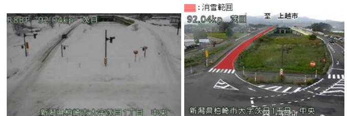
図-13 柏崎高架橋区間に消雪パイプ設置
