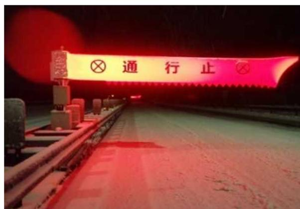
写真1. エア－式遮断機作動状況
