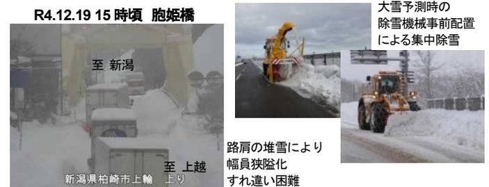
図-12 路肩幅員狭小の胞姫橋、上輪橋付近に除雪機を事前配備
