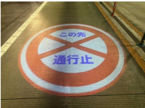
写真 4. プロジェクターによる通行止案内(車線上)
