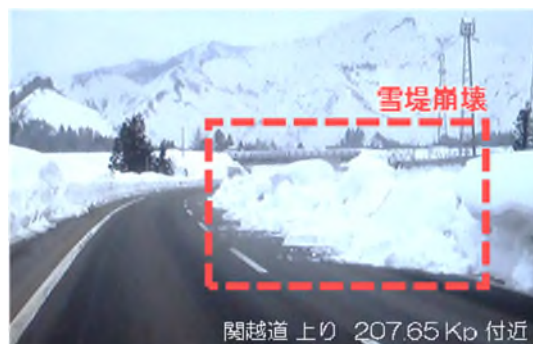
図-1 高速道路上で発生した雪堤崩壊
