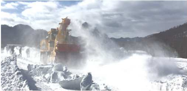
写真-2 夕張TCでの除雪負荷確認試験の様子
