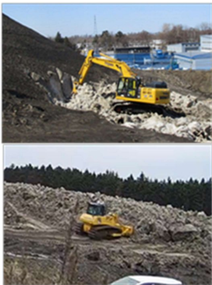
図4 遠隔操作による除雪作業状況 (上) バックホウ (令和4年) (下) ブルドーザー (令和5年)
