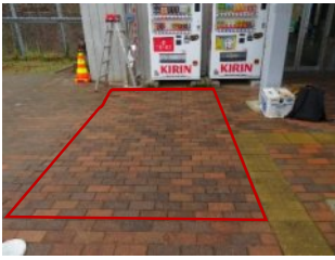
(写真-5) 外観近景
