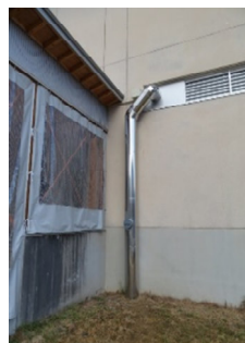
(写真-2) 縦配管外観
