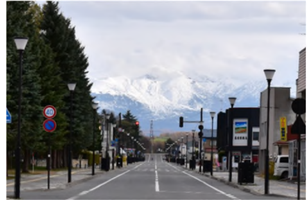
写真-1 無電柱化（地中化）された道路景観
