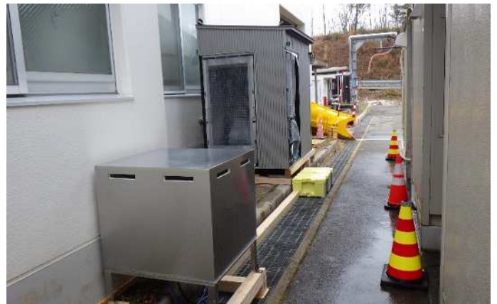
写真7 設置完了状況
