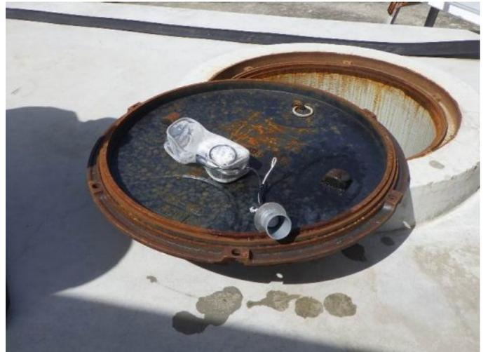
写真-7 超音波式水位計
