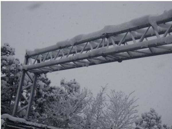
写真1 門型柱に着雪した状況
