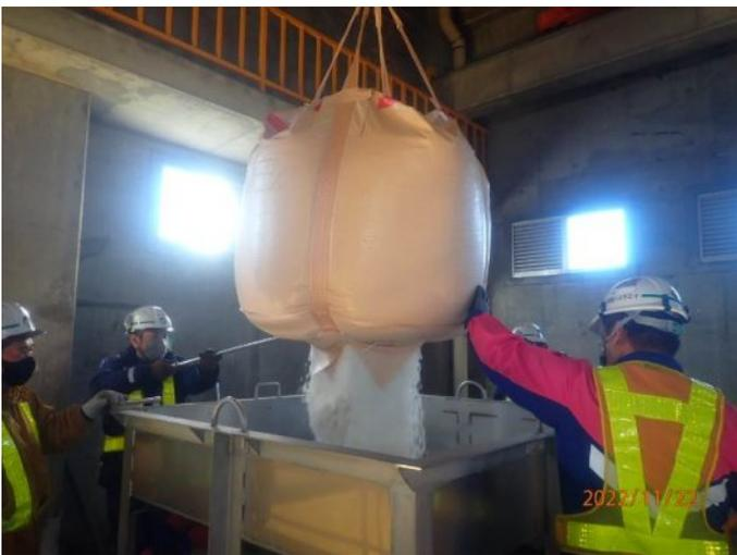
写真-11 DDホッパー1t塩ナト投入状況
