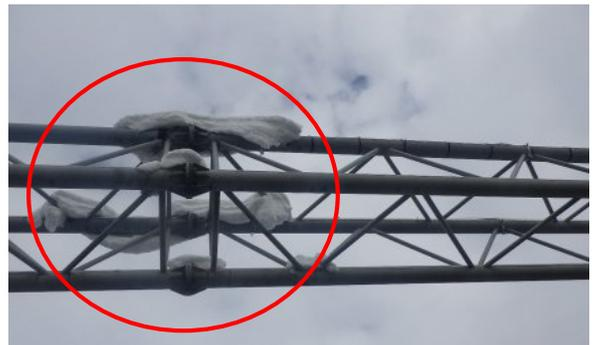
写真6 フランジ部・トラス部の着雪状況
