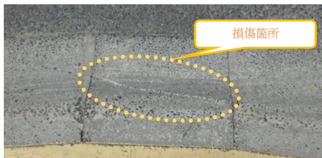
図4 端部損傷状況
