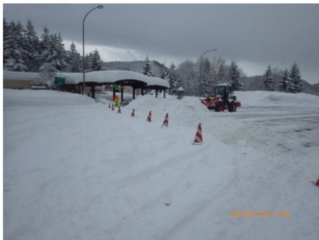
写真-2 山内PA タイヤショベル(1.3m<sup>3</sup>)作業状況
