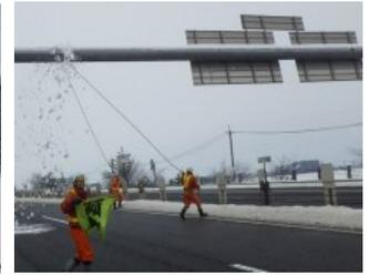
写真3 車線規制での除去 写真4 丸形鋼構造着雪除去
