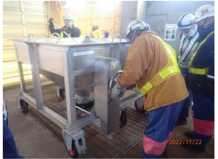
写真-13 DDホッパーからの投下調整状況
