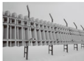
路側設置型防雪柵
