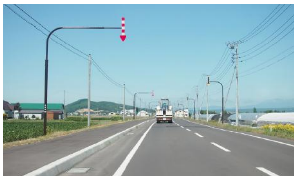
写真-5 ダークブラウンの標識柱が開放的な景観を損ねている事例（より太いはずの電柱よりも目立つ）
