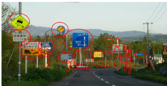
写真-5 多くの道路附属施設が設置された例
