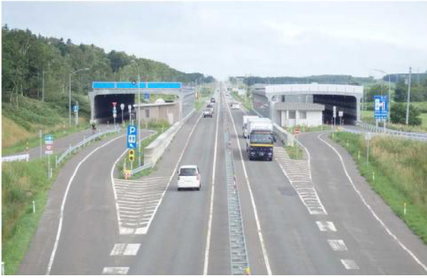
図-19 分割移設した開源パーキングシェルター
