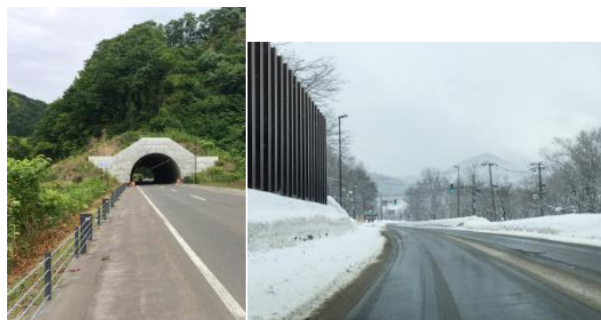
写真-7 ダークグレーを採用した道路附属物の例 （国道 230 号、札幌市南区定山溪） ※左写真の防護柵支柱、右写真の照明柱
