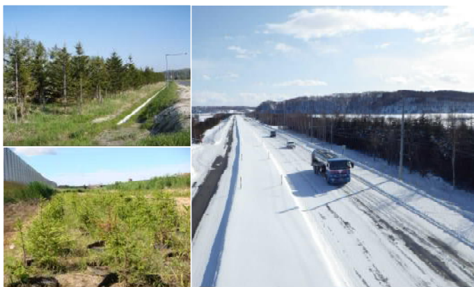
図-6 更喜苦内防雪区間に設置した両側防雪林
