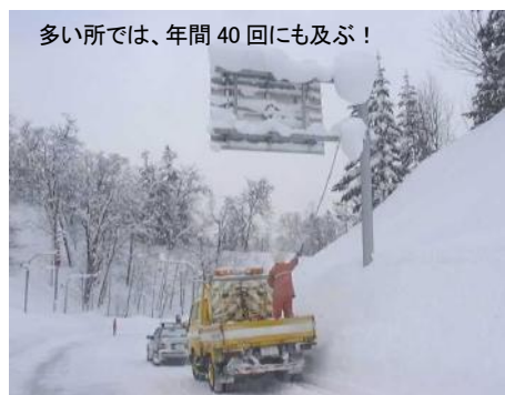
写真-6 F型標識背面の人力除雪作業 作業に伴うコスト増大
