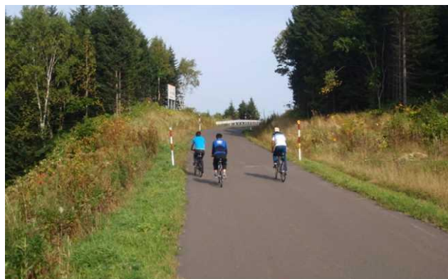
図-13 更喜苦内防雪区間に設置した防雪林管理用道路（副道）
