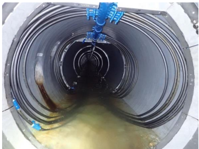
写真-3 下流側採熱ヘッダー（カバー設置前）
