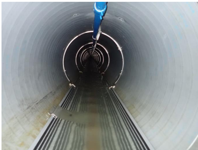
写真-2 下水管内の採熱管敷設状況
