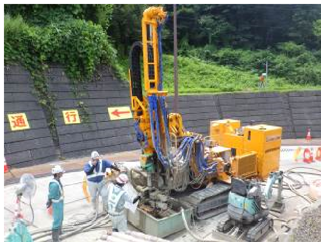
写真 1 採熱孔掘削状況
