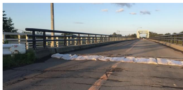
写真-2 橋梁部段差の解消
