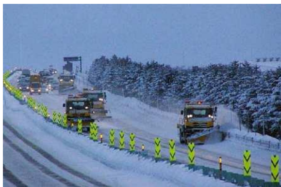
図8. パワー除雪の様子
