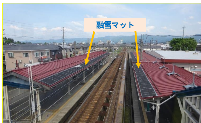
写真1 雪庇防止用屋根融雪装置
