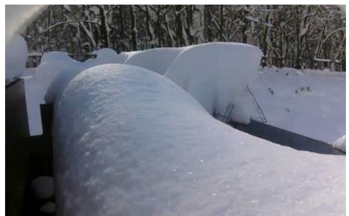
図7 支柱上部の多量降雪
