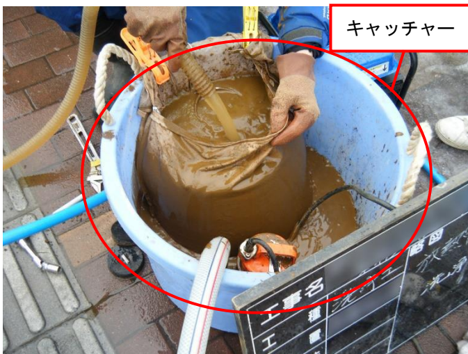
写真6 キャッチャーでのスケール回収状況
