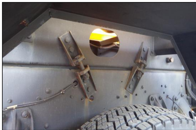
写真-3 塗料A シャシフレーム外側状況
