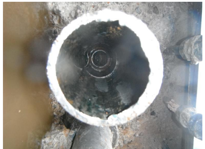
写真8 洗浄後管内スケール除去確認
