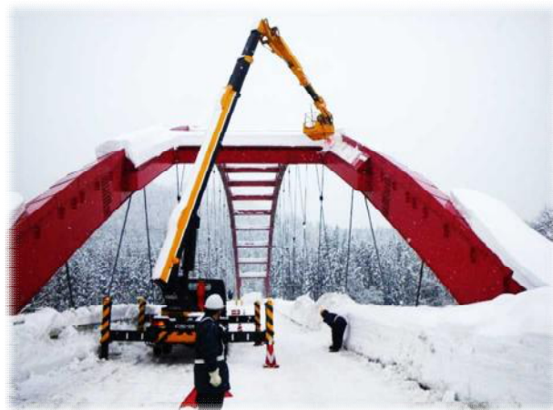
写真1 橋梁部の維持管理（雪底処理）状況
