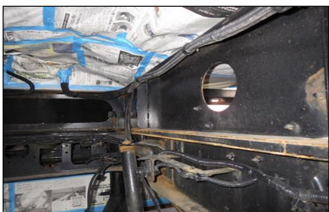
写真-6 塗料B シヤシフレーム内側状況
