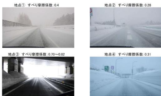
図 1 9 2月17日8:18のBランプの観測地点と路面状況
