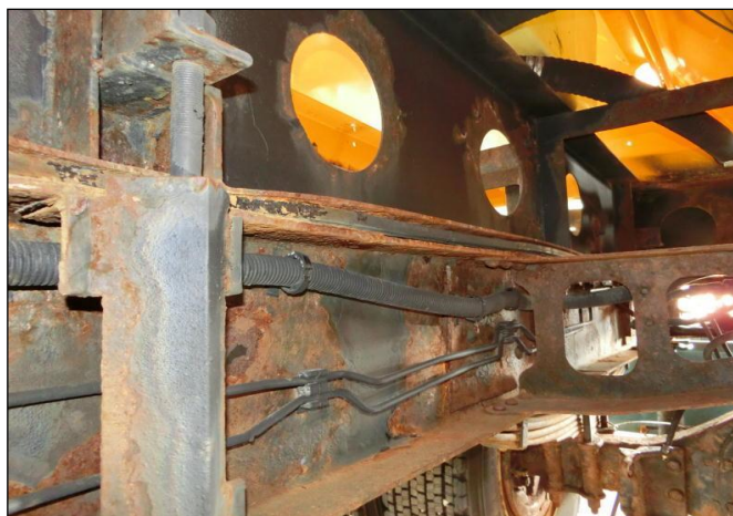
写真-1 シャシフレーム内側状況
