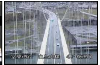
写 6 CCTV カメラ画像
