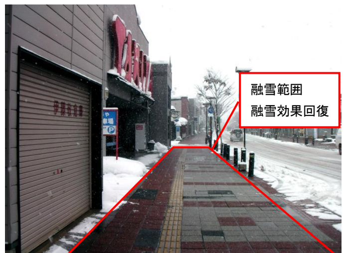
写真9 放熱管洗浄後の融雪状況
