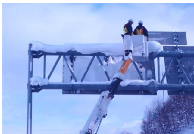
図2 道路標識に発生した冠雪の除去作業
