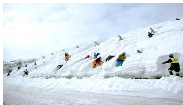
写真2 斜面の維持管理（雪底処理）状況
