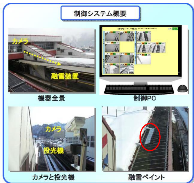
写真2 機器及び設置状況
