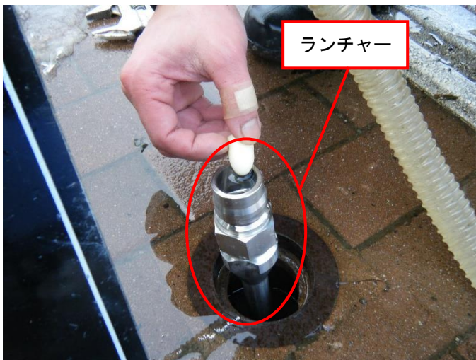
写真5 洗浄用ピグのランチャーへの挿入状況
