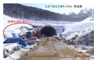
写真5 トンネル坑口部の崩落雪状況
