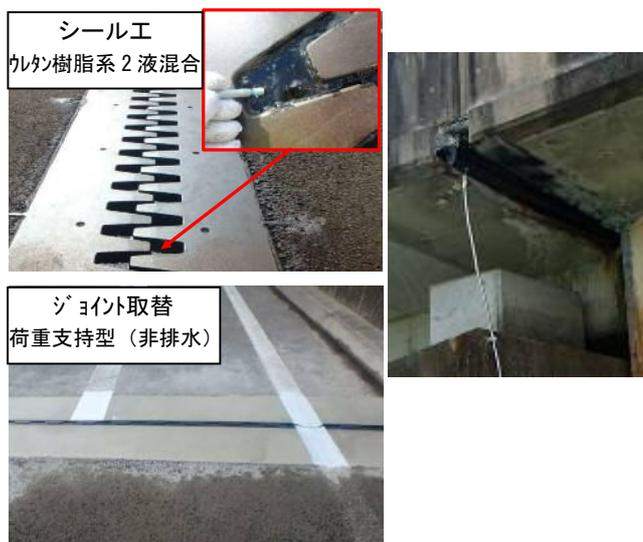
写真2 ジョイント漏水緊急対策
