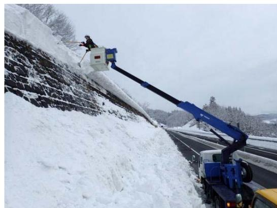
写真-4 人力による雪庇落とし状況
