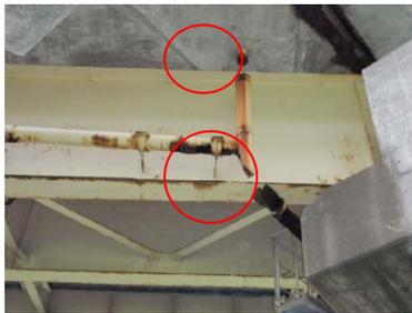
写真-1 排水管の劣化状況
