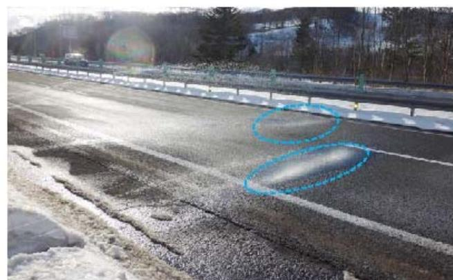
写真-3 凍結防止剤散布状況
