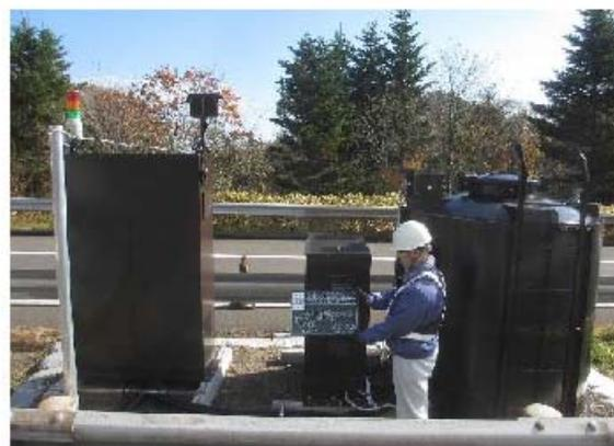
写真-1 定置式凍結防止剤散布装置と薬剤タンク
