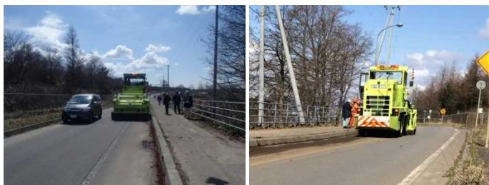
写真-3 作業状況（側道部）
