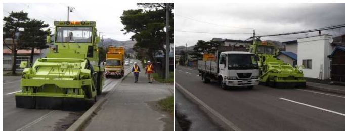
写真-4 作業状況（2車線道路）
