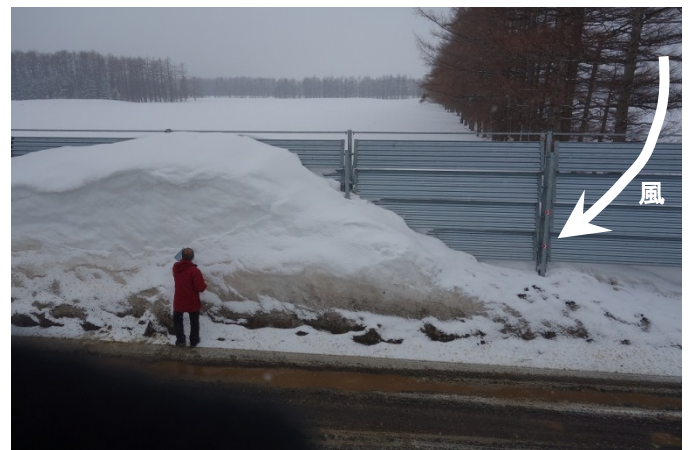
写真1 吹き払い柵の風上側の樹林が吹き払い機能に影響を与えている事例（2015年3月）。
