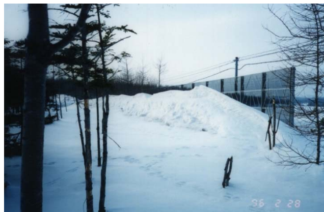
写真3 一般国道243号弟子屈町仁多防雪林の雪丘害
