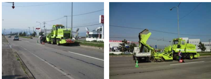
写真-7 土砂排出状況（中央分離帯）
