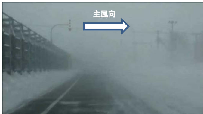
写真5 道路風下側路側の雪堤が吹き払い柵の吹き払い機能に与えている影響。上：雪堤がない場合、下：風下路側に雪堤がある場合。
