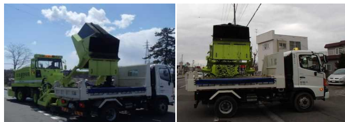
写真-5 土砂排出状況（2車線道路）
