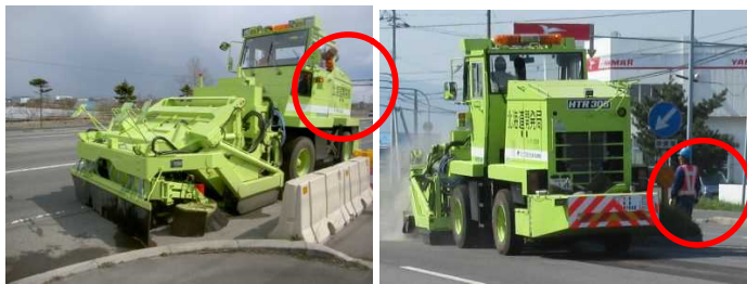
写真－8 施工中のブラシ確認状況
