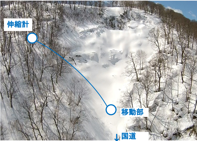
図 9 設置事例（宮城県）
