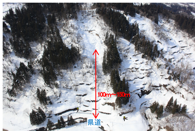
図 6 設置事例（新潟県上越地方）
