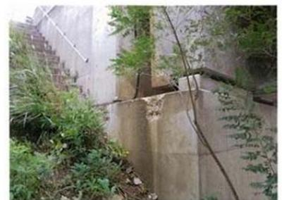
写真-12 熊出赤川橋 検査路の破損状況
