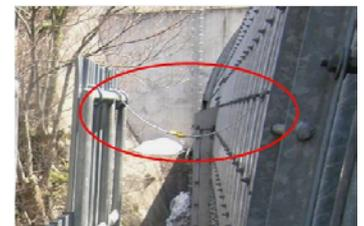
写真-4 折りたたみ構造 ワイヤ設置部
