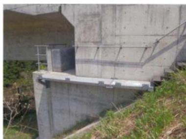
写真-11 小網川橋 検査路の破損状況
