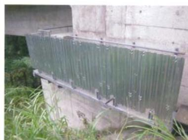
写真-14 小網川橋 折りたたみ構造の検査路
