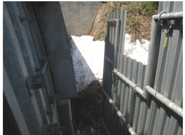
写真-9 名平橋 折りたたみ構造の検査路 終冬期の機能確認状況
