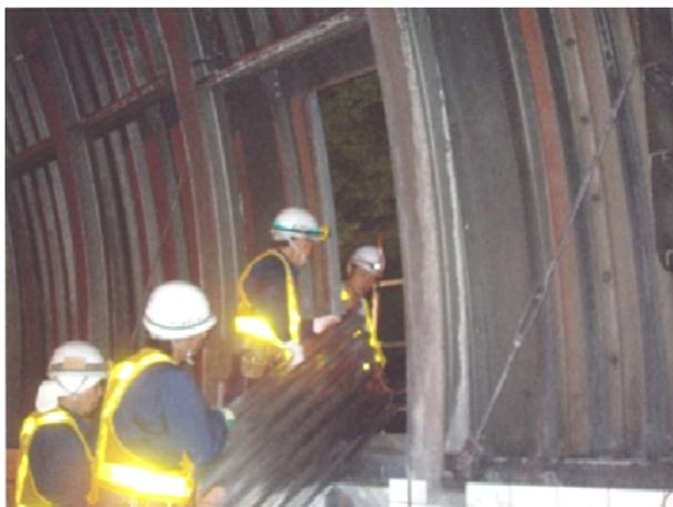
写真-6 名平橋 折りたたみ構造の検査路 施工時 材料搬入
