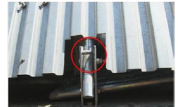
写真-3 折りたたみ構造 手摺の可動部
