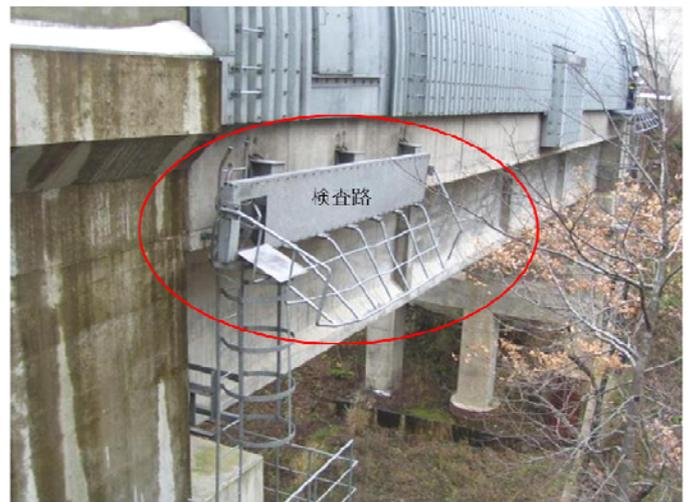
写真-1 名平橋 検査路の破損状況
