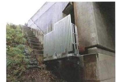
写真-15 熊出赤川橋 折りたたみ構造の検査路
