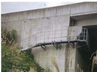
写真-10 角田川橋 検査路の破損状況
