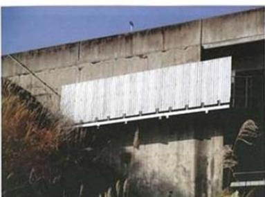
写真-13 角田川橋 折りたたみ構造の検査路
