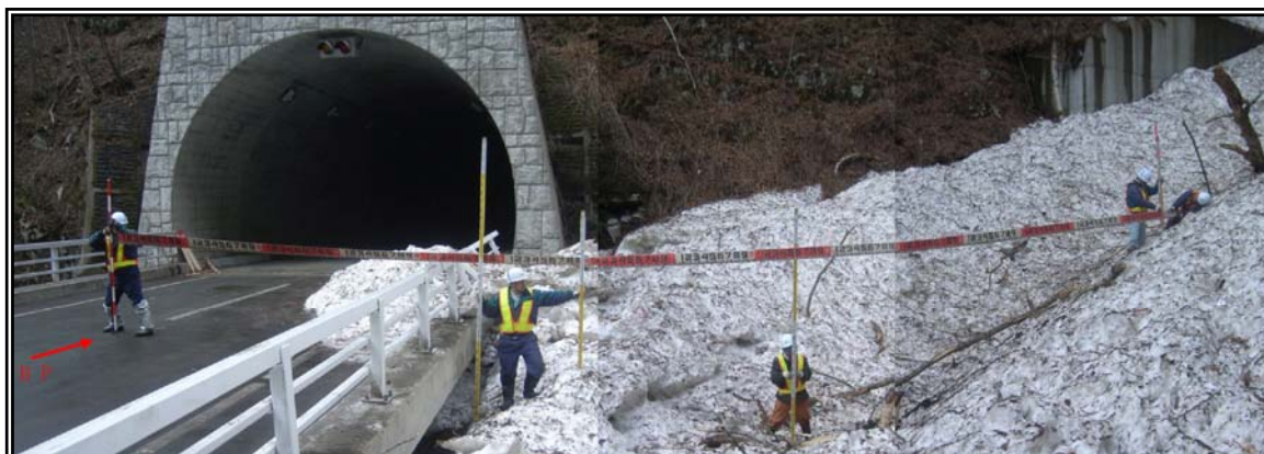
写真 1 雪崩衝突状況全体撮影
