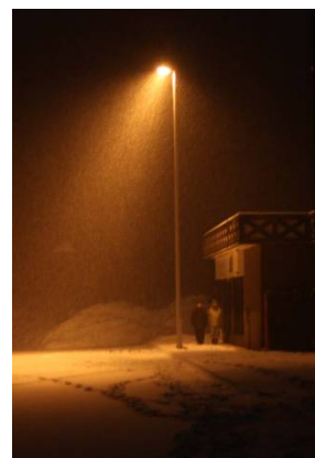
高圧ナトリウム照明
