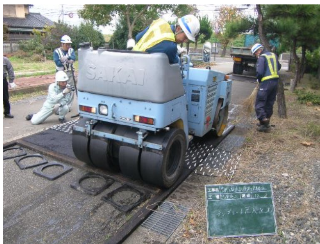
写真-3 試験施工状況
