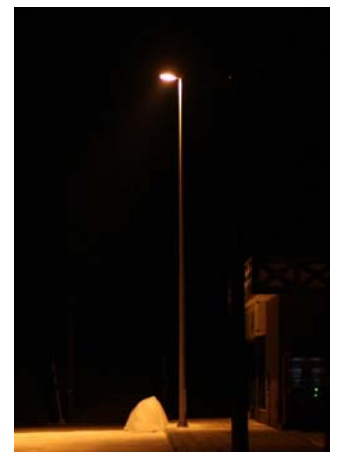
高圧ナトリウム照明
