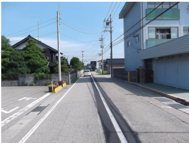
写真-8(施工箇所)
