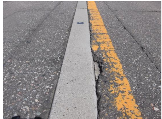
写真-5 (取付舗装の破損)
