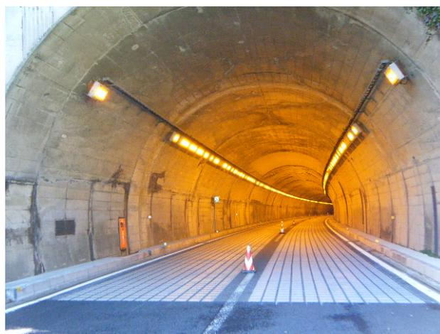
写真－4 凍結抑制舗装の完成状況
