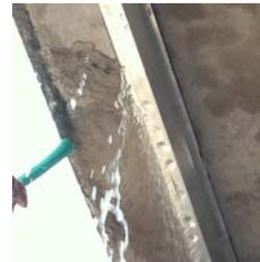
写真-6 底板下面滞水状況
