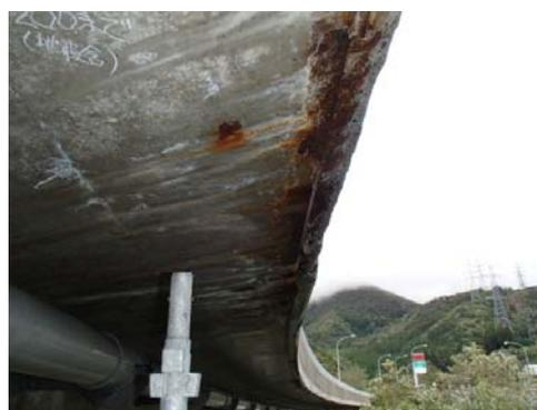
写真-2 地覆下面・張出下面損傷状況
