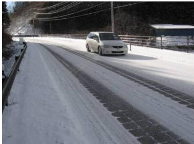
写真-5 一般道における凍結抑制舗装
