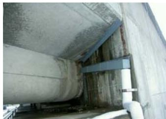
写真-4 L型板による水切り
