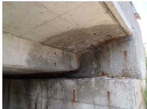
写真-1 橋梁桁端部損傷状況
