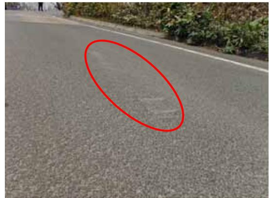
写真 - 11 除雪作業で発生したと思われる削り傷痕
