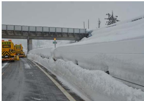
写真 3 アタッチメントによる雪堤切り作業
