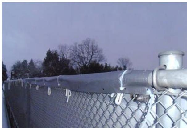
図-8 落下物防止柵の上胴縁のシート設置状況
