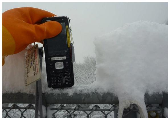
図-7 落下物防止柵の上胴縁の雪庇状況
