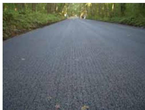
写真-1 縦溝粗面仕上げの例
