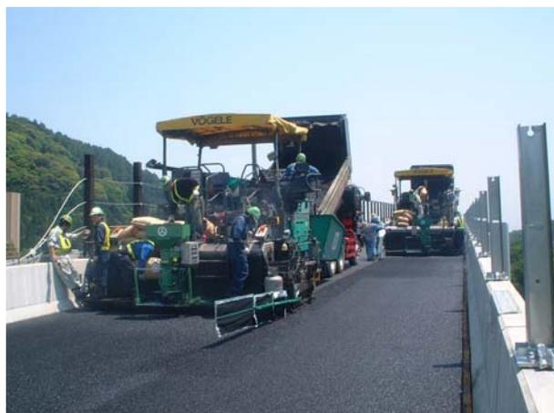
写真-5 ポーラス混合物型の施工状況
