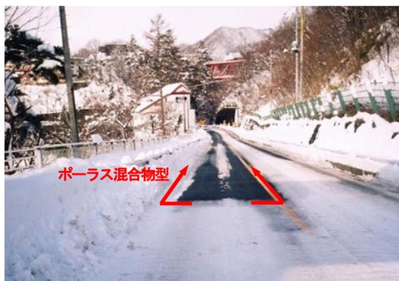
写真-8 ポーラス混合物型の冬期路面状況
