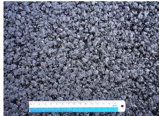
写真-3 ポーラス混合物型の舗装表面
