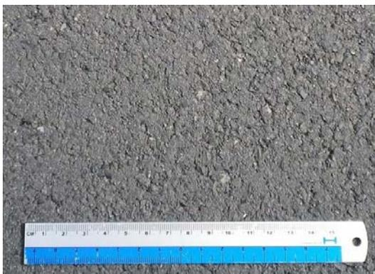
写真-2 薄層型の舗装表面
