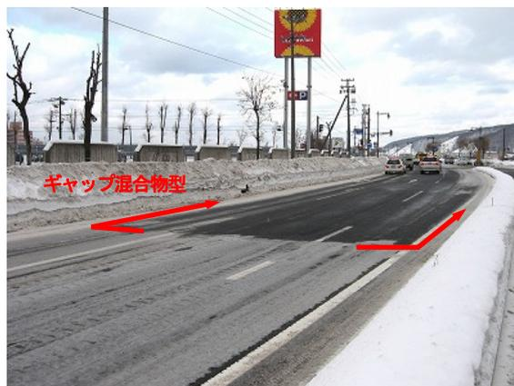
写真-7 ギャップ混合物型の冬期路面状況
