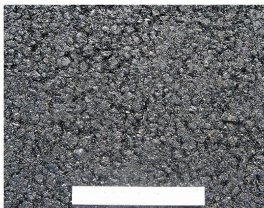
写真-6 粗面型の舗装表面
