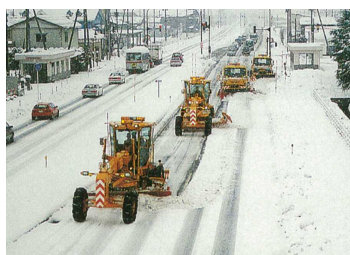
写真-7 梯団除雪の状況
