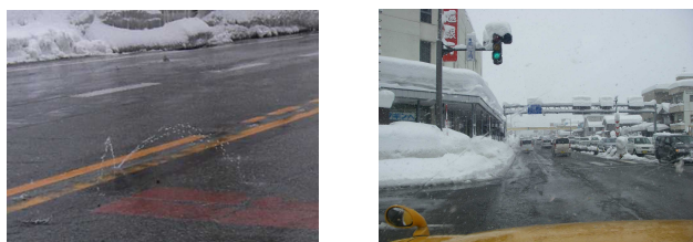
写真-6 消雪パイプ
