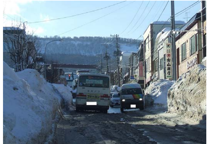
写真2 路面の凹凸状況
