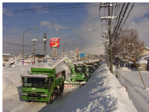
写真-1 道道深川雨竜線の運搬排雪状況
