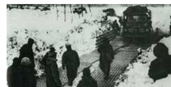
写真-5 鉄板を敷いた緊急輸送
