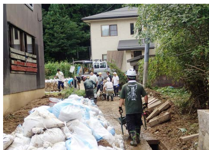
写真 6 ボランティアによる土砂出し作業①
