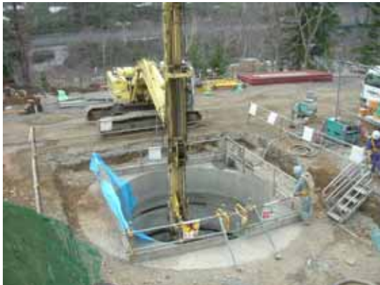
・ 基礎掘削状況
