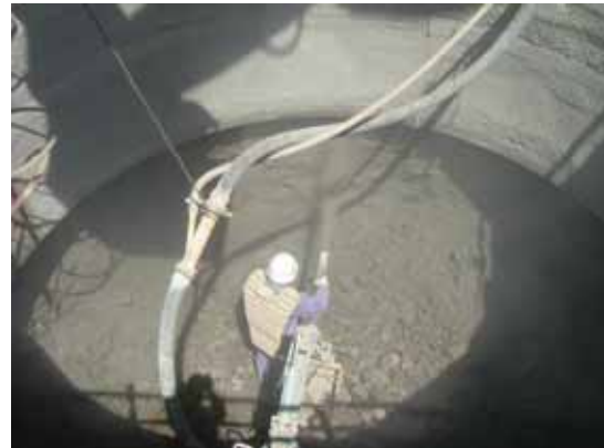
・ 吹付コンクリート施行状況
