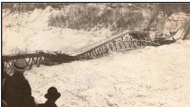
図 2-3-1(2) 国外での被害事例(河氷のアイスジャム・パイルアップによる橋の崩壊)
