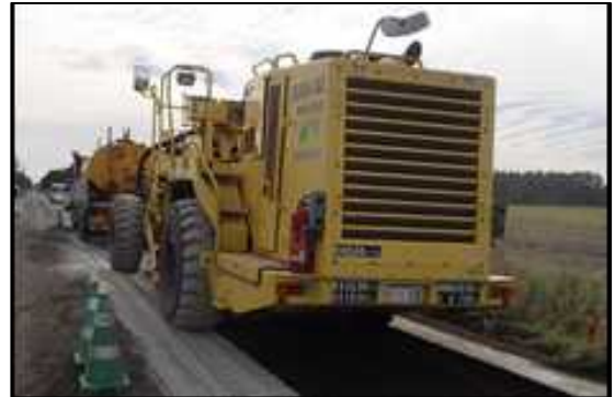
技術相談を受けた箇所の施工状況(事例2)
