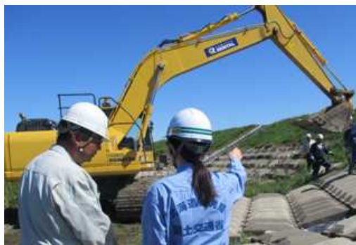
▲河川堤防の緊急復旧 (胆振東部地震時)
