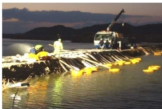
▲24時間体制の排水作業 (東日本震災時)
