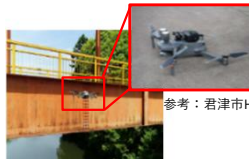
ドローンによる橋梁点検
