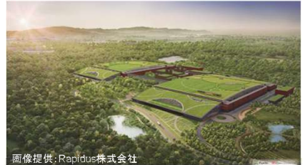
次世代半導体工場周辺インフラの整備
