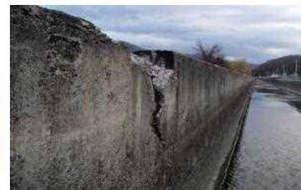
凍害による用水路側壁の亀裂
