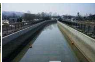
改修後の用水路
