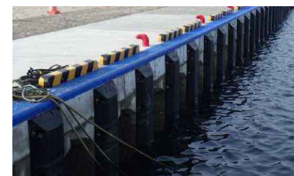
岸壁の老朽化対策例
