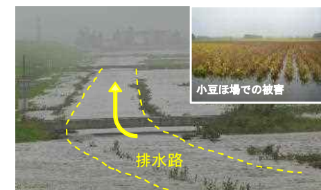
大雨時の湛水被害
