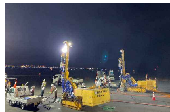
滑走路の液状化対策 (新千歳空港)
