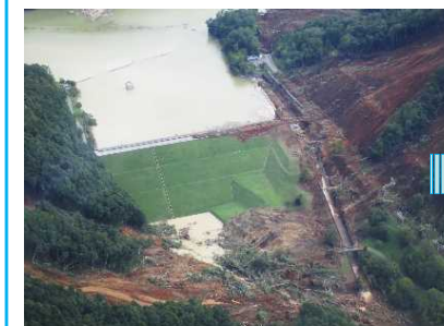
厚真ダムの被災
