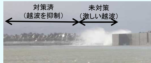
対策効果例（越波を抑制し、海上交通ネットワークを維持）
