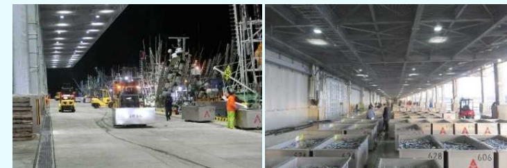
衛生管理対策施設(厚岸漁港 令和2年8月供用)
