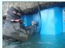
漁港における防波堤の老朽化対策 (鋼矢板の被覆防食)
