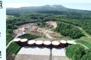
樽前山覚生川2号砂防堰堤 （苫小牧市）
