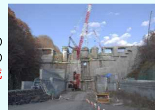
工事中の平取ダム（平取町）
