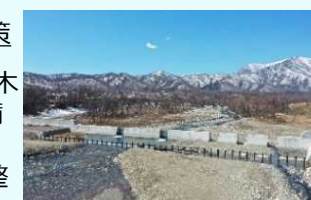
十勝川水系戸鶯別川 第2号砂防堰堤（常広市）
