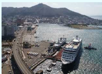
函館港 若松地区 クルーズ船岸壁水深8mの暫定供用(4万t対応)(平成30年10月)
