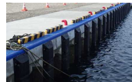
岸壁の老朽化対策例
