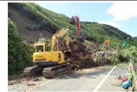
令和2年8月 土砂撤去作業 (国道238号 稚内市)
