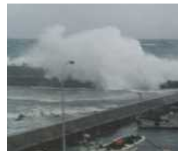
防波堤からの越波 (江良漁港)
