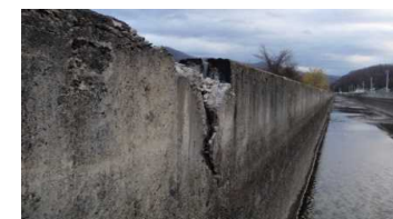
凍害による用水路側壁の亀裂
