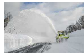
令和3年2月 除雪作業 (国道275号 幌加内町)
