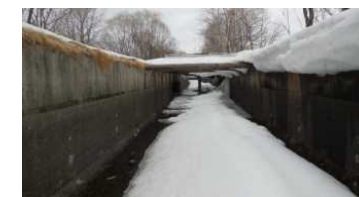
雪庇の影響を受ける用水路
