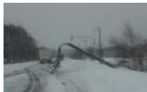
暴風雪による電柱の倒壊 (大樹町 国道336号)
