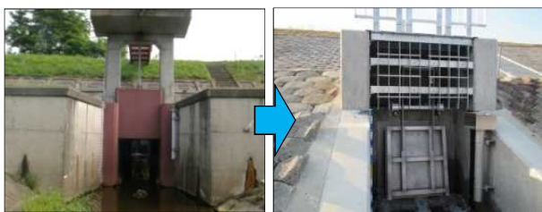
引き上げ式ゲートからフラップゲートへの更新
