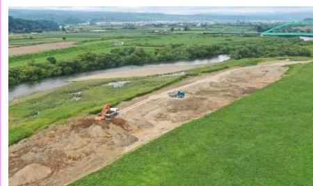
氾濫をできるだけ防ぐ河道掘削
