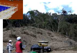
ドローンによる測量・写真撮影
