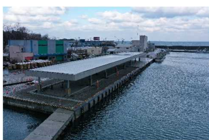
屋根付き岸壁（増毛港）
