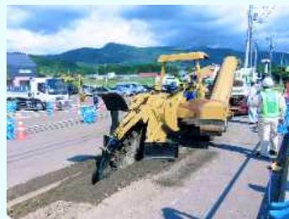
トレンチャー機械による掘削の試験施工
