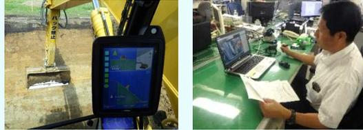
ICT施工による掘削 遠隔臨場による検査
