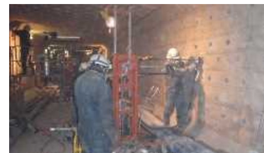
地下構造物の耐震補強
