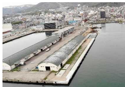
小樽港第3号ふ頭整備状況 (2021年5月時点)
