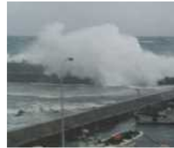
防波堤からの越波 (江良漁港)
