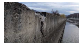
凍害による用水路側壁の亀裂
