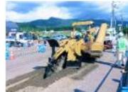
トレンチャー機械による掘削の試験施工 (国道5号 赤松街道電線共同溝)
