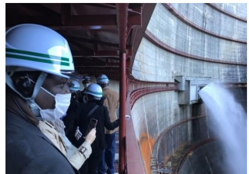
豊平峡ダム施設見学
