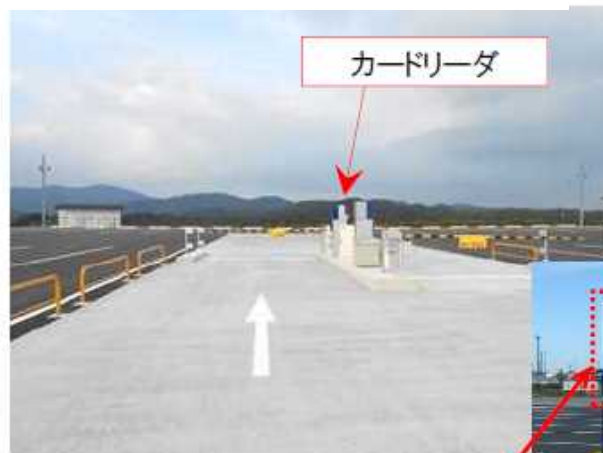
自動開閉入退場システム
