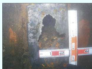
港湾における対策効果例 （矢板が腐食した係留施設を改良し、安全な利用を確保）
