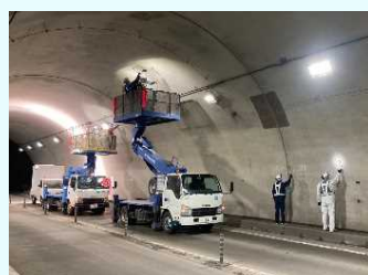
トンネルの点検状況
