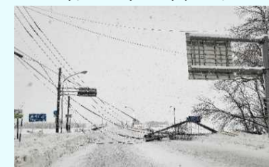
暴風雪による電柱倒壊 (幕別町 国道38号)
