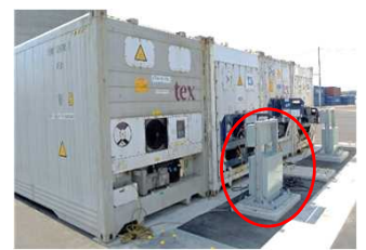
冷凍・冷蔵コンテナ電源供給装置の増設 (石狩湾新港)
