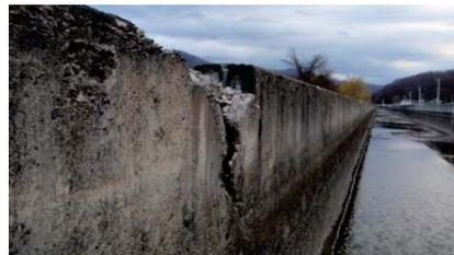
凍害による用水路側壁の亀裂
