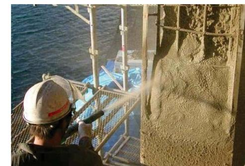
補修用モルタル吹き付けによるコンクリート欠損等の修復イメージ
