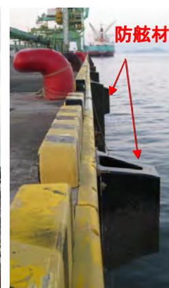
大型クルーズ船に対応した係船柱及び防舷材の整備
