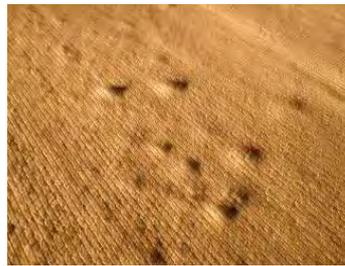
舗装の損傷（舗装の浮き上がり）
