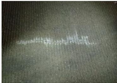
舗装の損傷（クラック）
