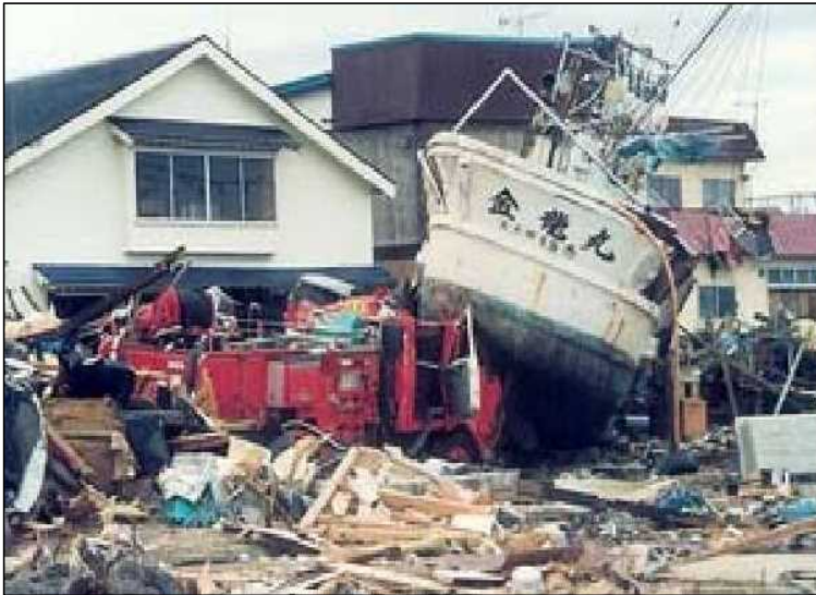
津波漂流物による被害の例（北海道南西沖地震時）
