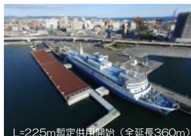
函館港大型クルーズ船岸壁整備状況 (2018年10月、水深8m暫定供用)
