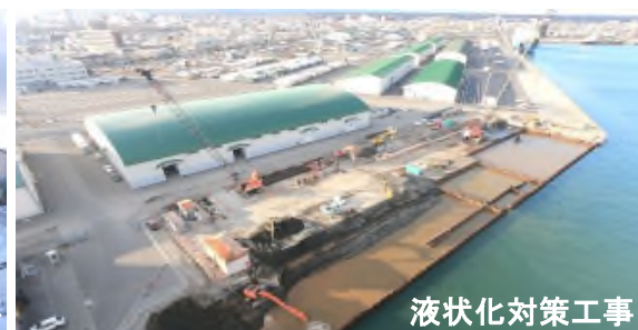
岸壁改良工事
