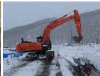
暫定的な用水路の敷設工事
