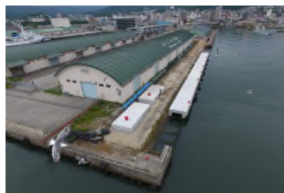
小樽港第3号ふ頭整備状況 (2018年7月時点)
