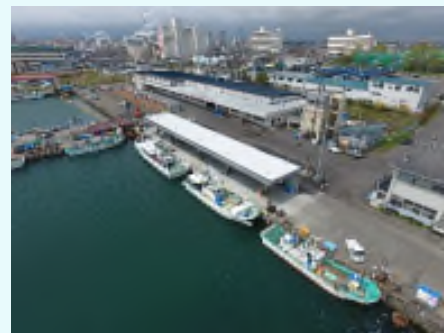
平成30年5月暫定供用 苫小牧港 屋根付き岸壁
