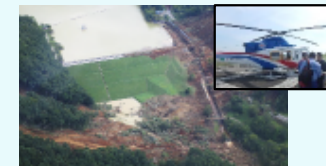
防災ヘリからの被災状況調査
