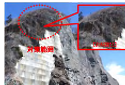
道路法面・盛土に関する緊急対策
