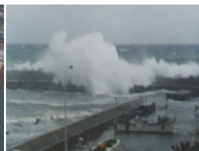
防波堤からの越波状況（江良漁港）
