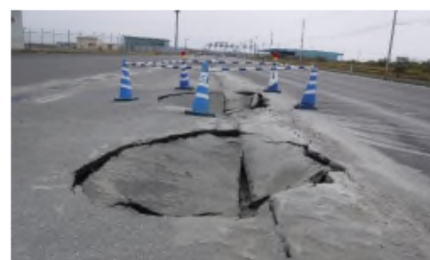
北海道胆振東部地震における液状化・陥没等の被害状況
